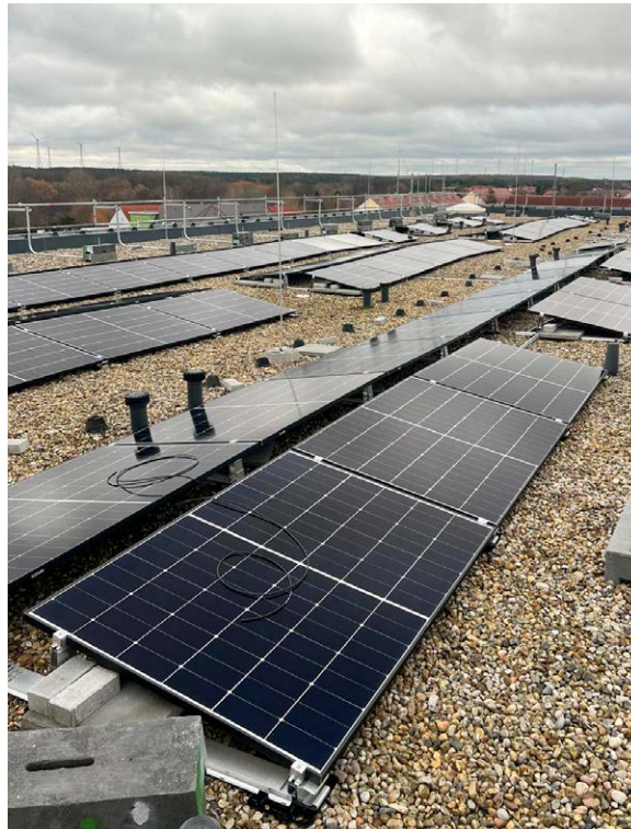
Auf den Dächern des Spremberger Krankenhauses sind die Photovoltaik-Anlagen montiert. Noch im ersten Halbjahr 2025 soll die Anlage in Betrieb gehen.
